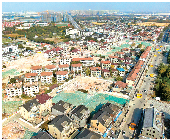
▲ 航拍改造项目现场 本报记者 刘歆 摄于2023年12月25日
