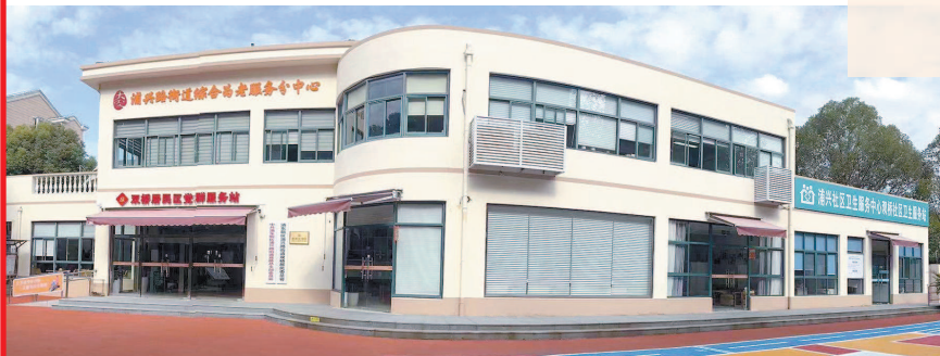
浦兴路街道综合服务中心
