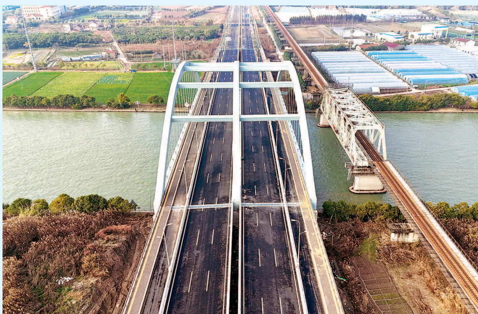
■ 金汇港大桥全长679.58米，跨越金汇港通航河道，主跨为125米的下承式钢箱梁系杆拱桥 受访者供图
