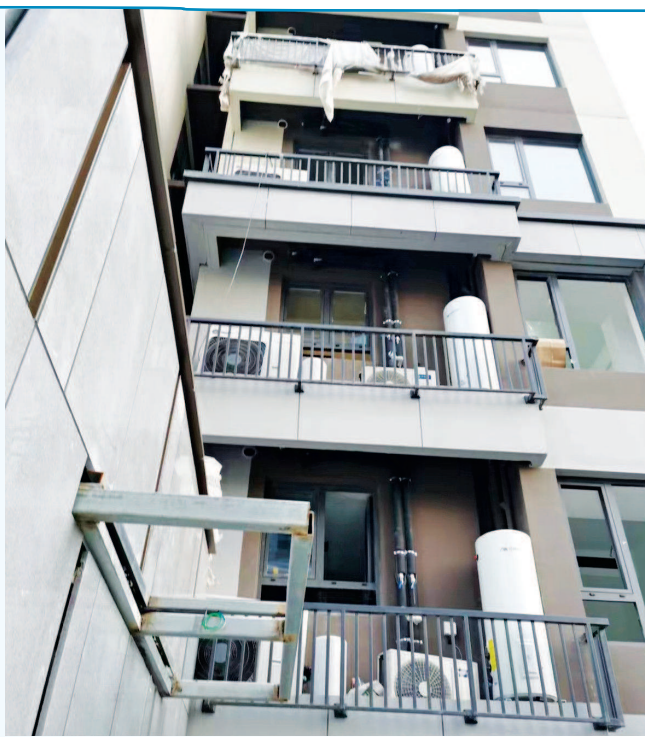
■ 查询显示,安装前未取得认证 ■ 热水器水箱安装位置有隐患 ■ 新楼盘空气能热水器由开发商统一安装 均为业主供图
