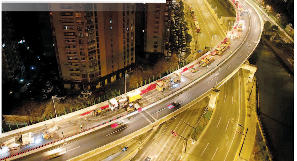
夜间施工现场
