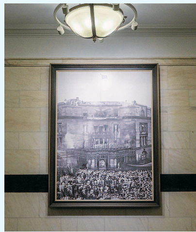
▲ 五星红旗在江西中路215号升起的老照片 ◀ 改造后的老市府大楼正门 本报记者 周馨 摄
