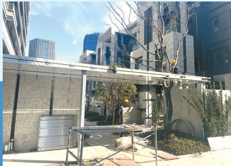
记者探访当日,地下车库、儿童乐园等仍在建造中
