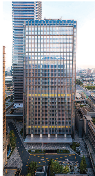
「高·尚领域」T2办公楼外观实景图
