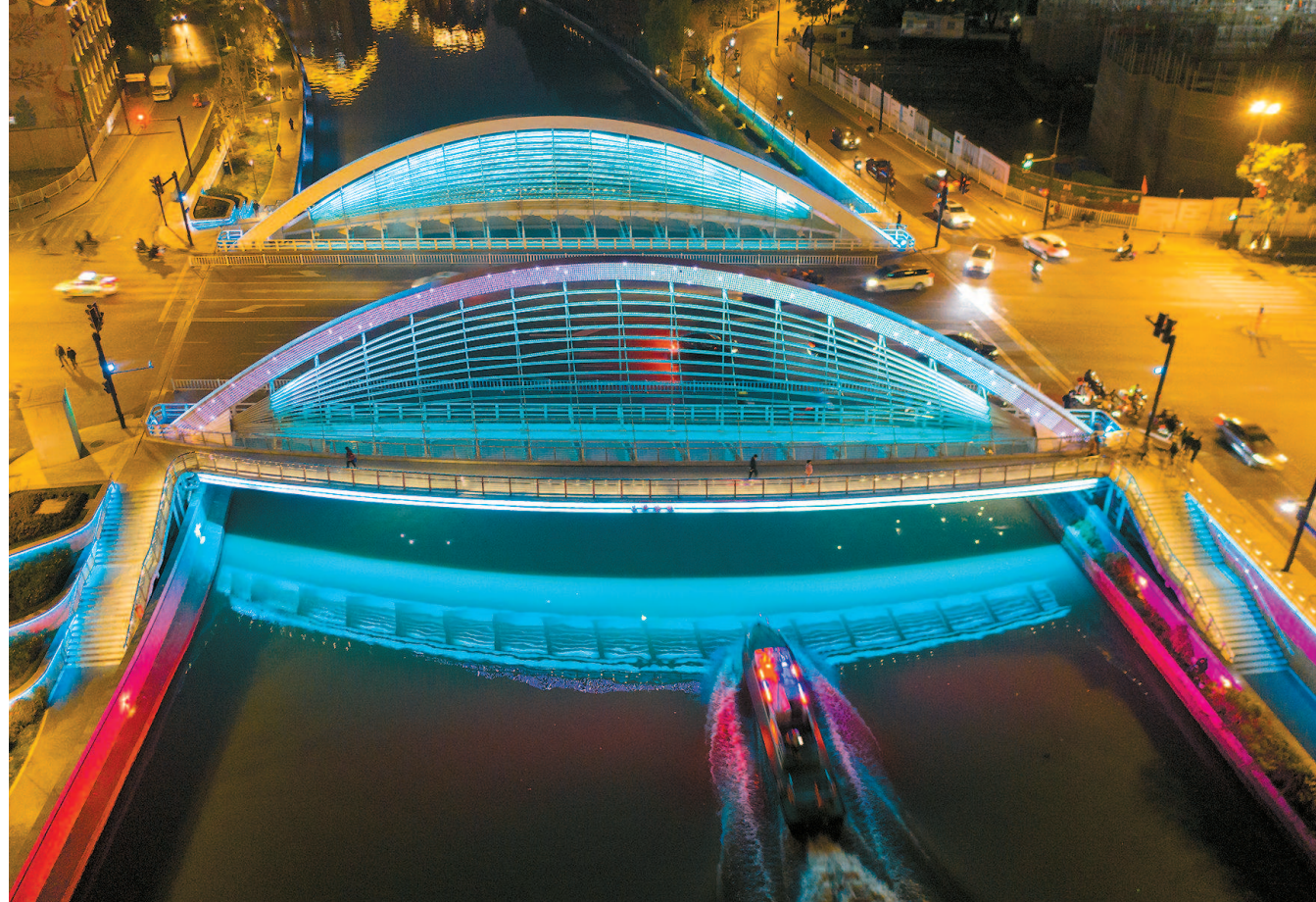
被誉为“苏河之眼”的昌平路桥照明采用太阳能光伏发电供电,桥底还设置了“暗夜星空”的场景,采用无线控制方式与游船互动,“船来闪烁,船走暗夜”,增加了船行体验感 本报记者 周馨 摄
