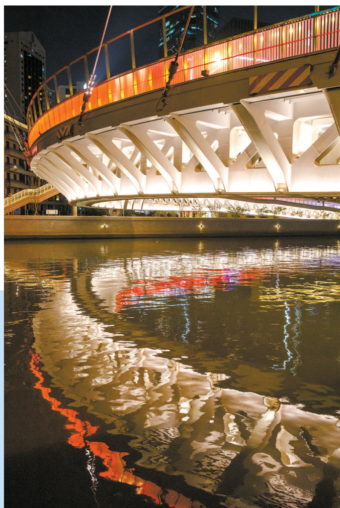
安远路桥栏杆采用一体式发光板。常态模式时,栏杆为单色光,节假日模式时,开启幻彩互动功能 本报记者 周馨 摄
