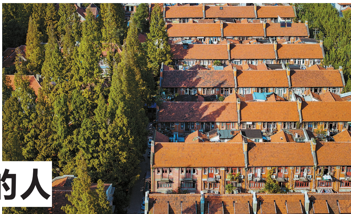
VV大陆新村建成于一九三二年，为砖木结构、红砖红瓦的三层新式里弄房屋。
