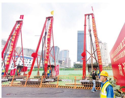
■ 蕃瓜弄小区旧住房“拆落地”改建项目上午开工 本报记者 周馨 摄
