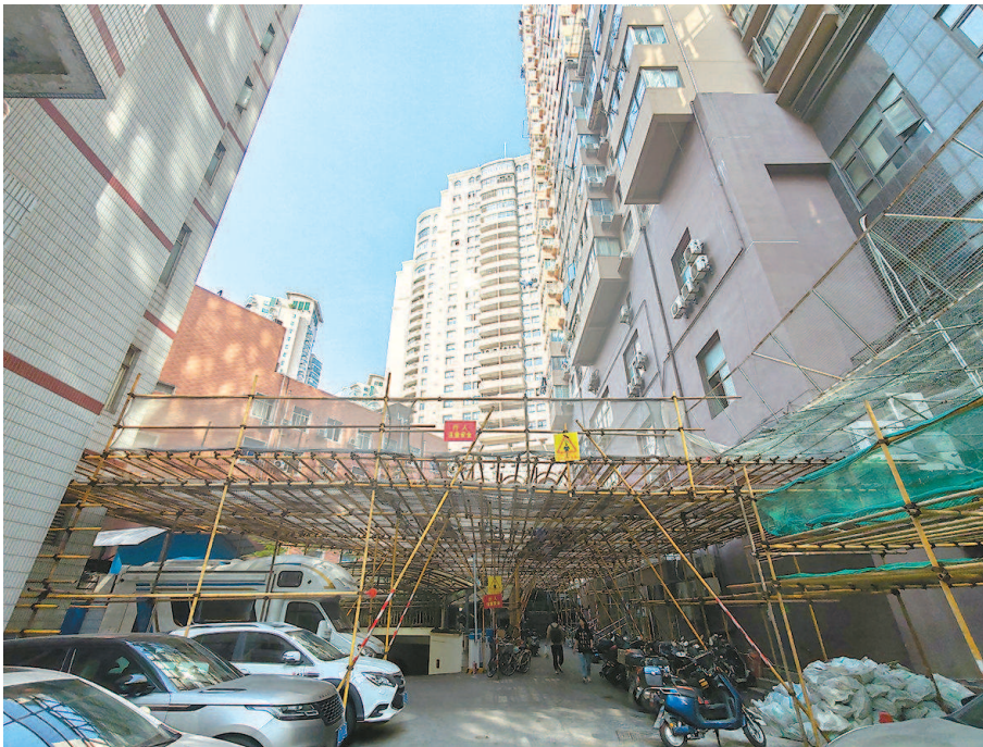
▲ 小区两幢大楼已采取防护措施，都拉起了数道安全防护网
