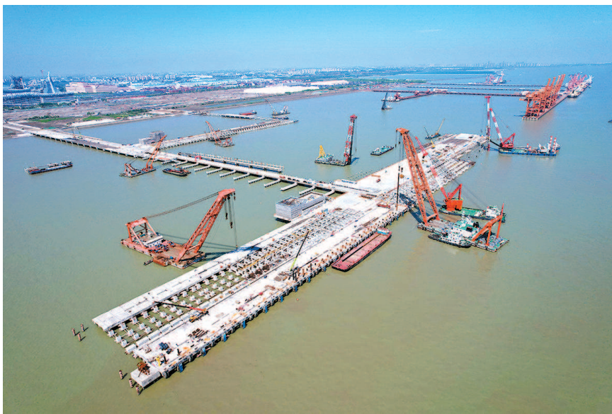
■ 施工高峰期,多条打桩船在现场同时进行沉桩作业
