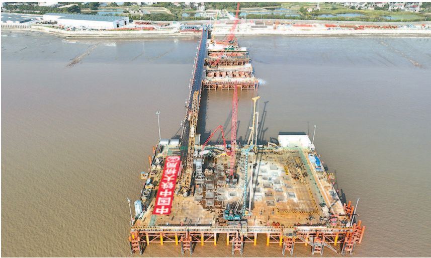
■ 杭州湾跨海铁路桥北航道桥8号主塔6号桩施工现场 采访对象提供
