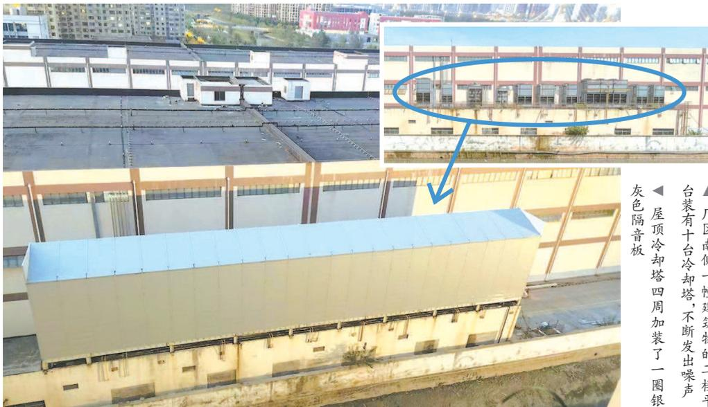
▲ 厂区内南侧一幢建筑物的二楼平台装有十台冷却塔,不断发出噪声
