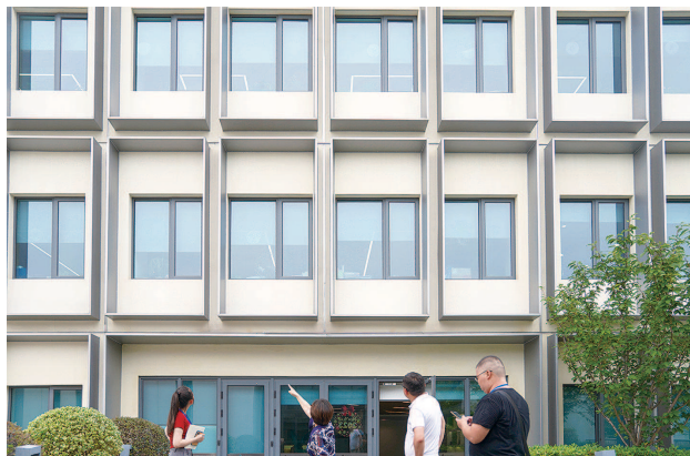
■绿色建筑示范建筑外墙采用的突出预制板能有效阻隔过强的阳光
