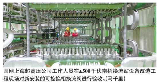
国网上海超高压公司工作人员在±500千伏南桥换流站设备改造施工现场对新安装的可控换相换流阀进行验收。(马千里)
