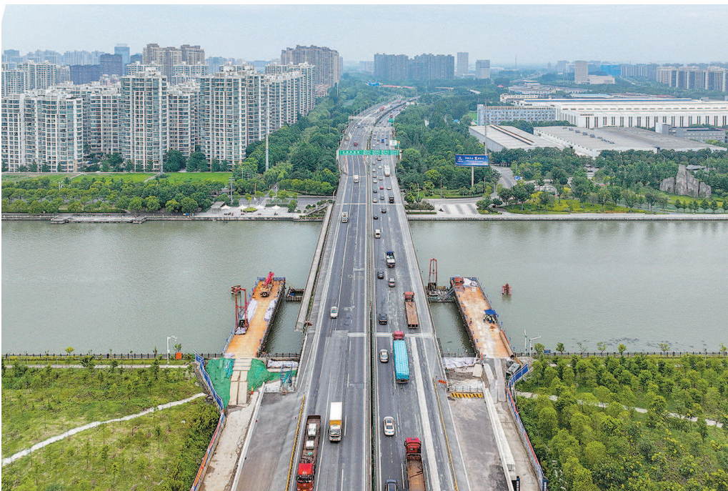
G15沈海高速嘉浏段新浏河大桥拓宽改建工程上午开工
