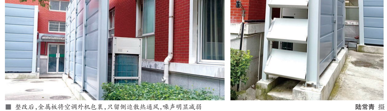
■ 整改后，金属板将空调外机包裹，只留侧边散热通风，噪声明显减弱 陆常青 摄
