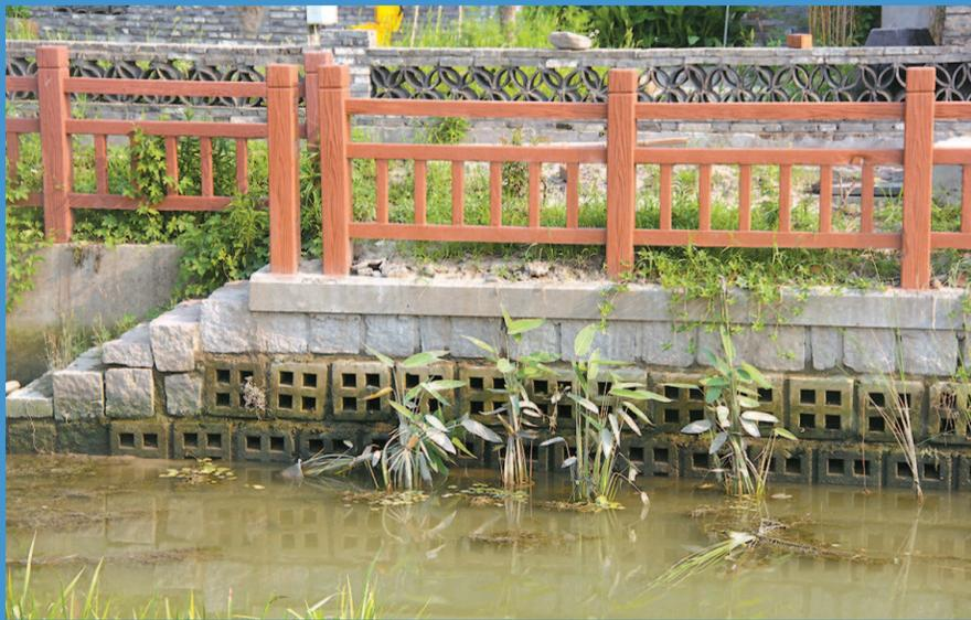
石湖荡镇东三河,呈“田”字形孔隙的石块堤岸
