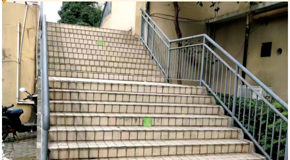
底楼是商铺,开发商交付时没有设置无障碍通道,居民上下要爬许多级台阶
