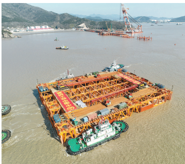
2023年2月16日,甬舟铁路西堠门公铁两用大桥5号墩自浮式钻孔平台由拖轮护送浮运 丁凯 摄
