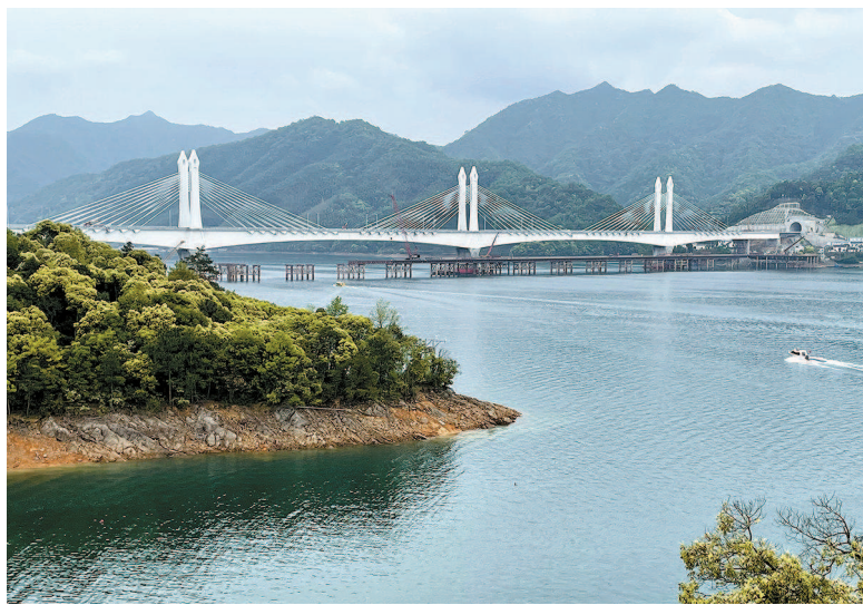
建设中的池黄高铁太平湖特大桥 许文峰 摄
