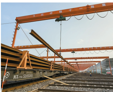
2023年6月1日,首批长钢轨运抵杭温高铁义乌铺轨基地后,工作人员正在卸车作业 黄晨阳 摄
