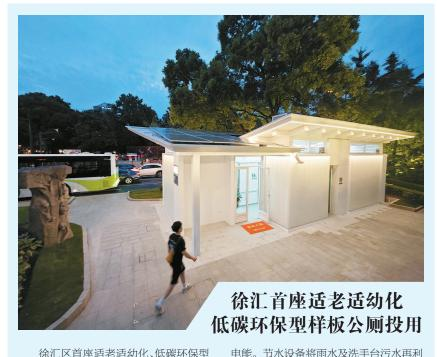
徐汇区首座话老话幼化, 低碳环保型 样板公厕——肇嘉浜路天平路公厕近日顺 利竣工并交付使用。公厕屋顶装有近110 平方米的太阳能光伏板,将太阳能转化为
