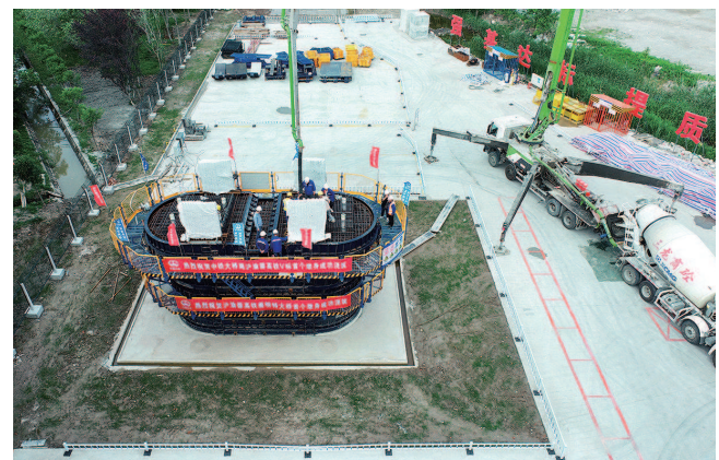
■ 崇明特大桥首个墩身浇筑作业现场
