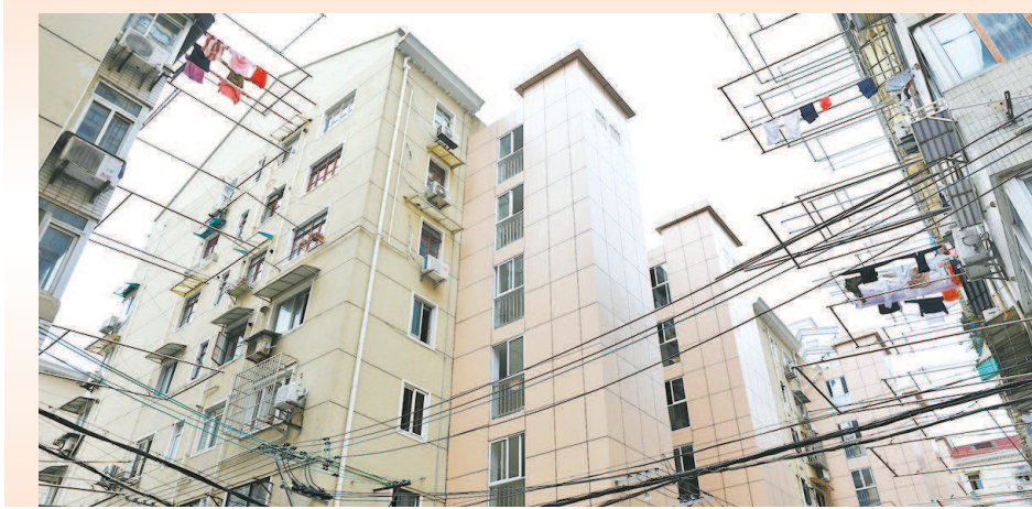
楼栋 ■蒙自西路七十二弄已经加装好电梯的 本报记者 周馨摄
