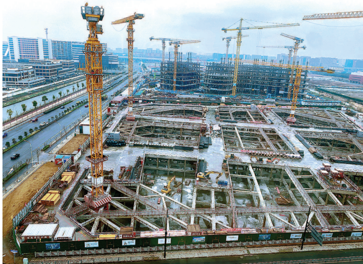
虹桥前湾地区在建工地塔吊林立
