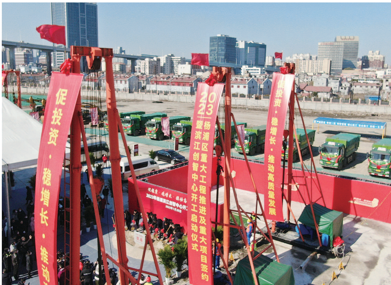
今天上午,杨浦滨江创智中心项目开工
