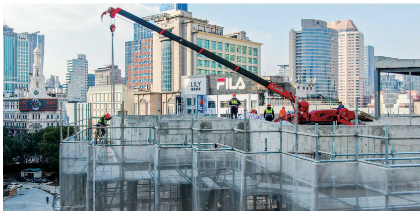
■ 世纪广场施工现场,工人们正在搭建钢结构
