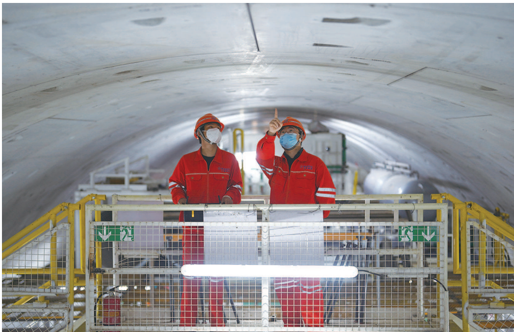
■ 盾构司机任帅(右)正在检查盾构管片
