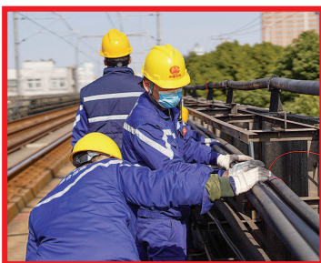
▲工作人员春节将加紧施工 ▶张华浜地铁站工地热火朝天 本报记者 陈梦泽 摄
