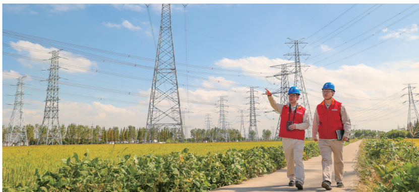
国网上海超高压公司输电运维人员开展重要输电通道巡视
