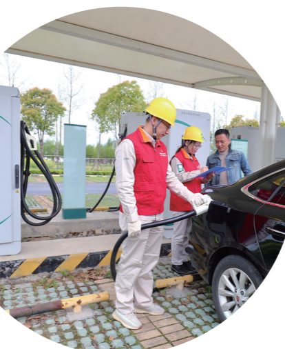
升级农村电网,推广电能替代技术,打造“双碳”实践样板和乡村振兴绿色能源发展示范
