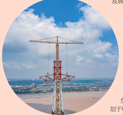
国网上海电力完成崇明500千伏输电变电工程(线路)长江大跨越铁塔封顶工作
