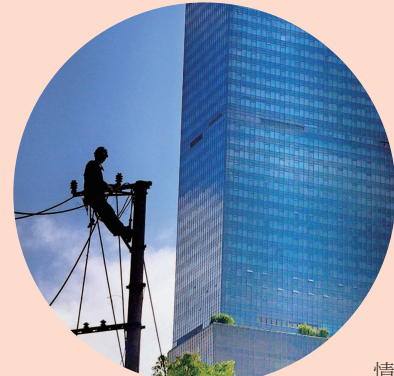
国网上海电力施工队在长宁路上实施电力架空线入地工程
