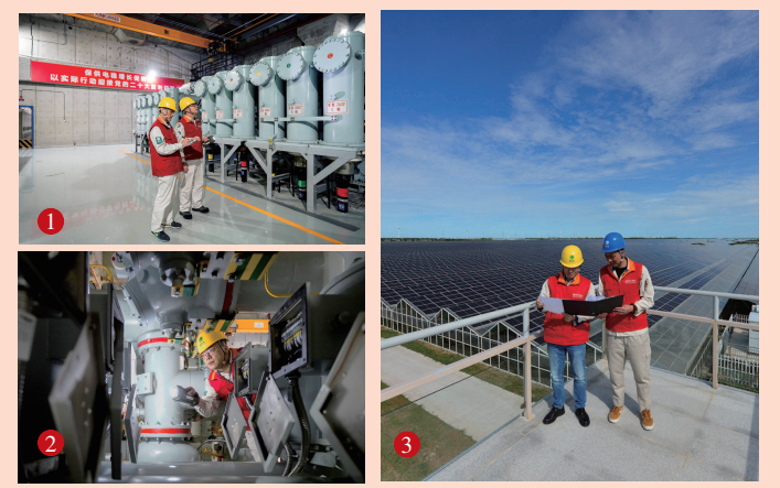
1 2 国网上海电力500千伏静安地下站增容改造工程进入新设备调试验收阶段
