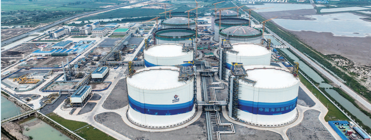
中国海油盐城“绿能港”项目现场
