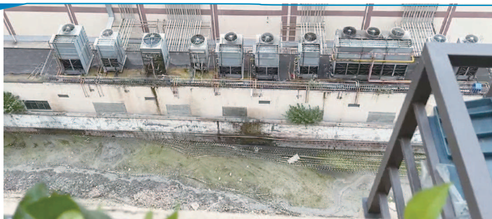
■ 与小区仅一河之隔的冷库24小时运转,十几个冷却塔周围无隔音设施遮挡
