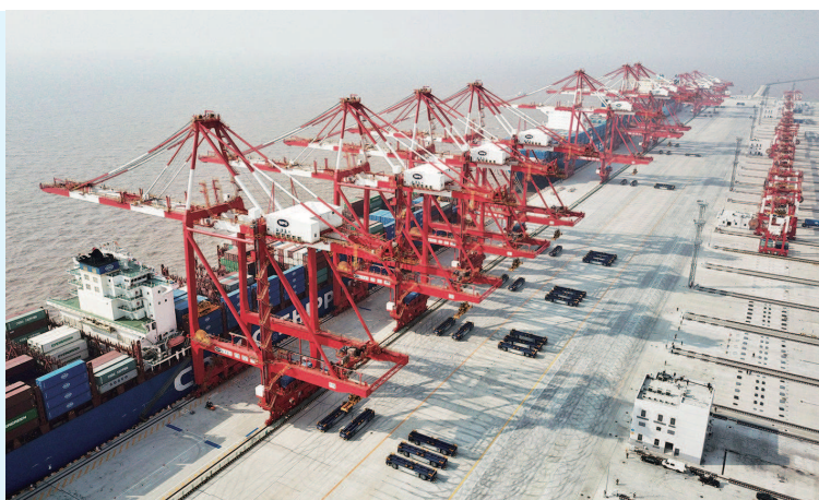
2017年12月，作为全球规模最大的自动化码头——上海洋山深水港四期码头正式开港试运行
