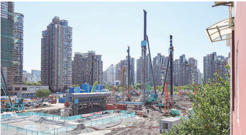
工地“近在咫尺”
