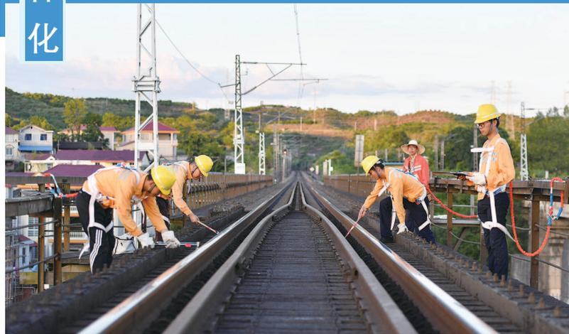
近日,湖南省怀化市持续高温天气,桥隧工们坚守岗位,避开高温错峰巡检。图为桥隧工在沪昆铁路新舞水钢梁桥巡检作业
