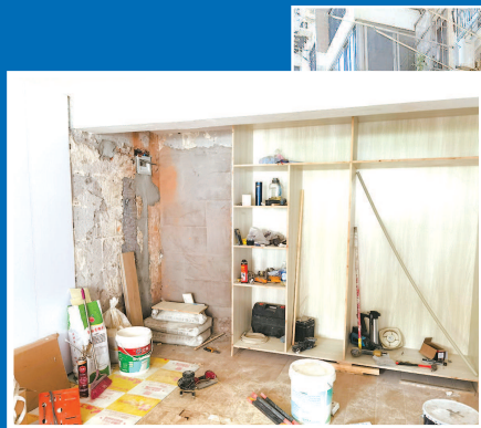
▲ 一间车库正在装修
