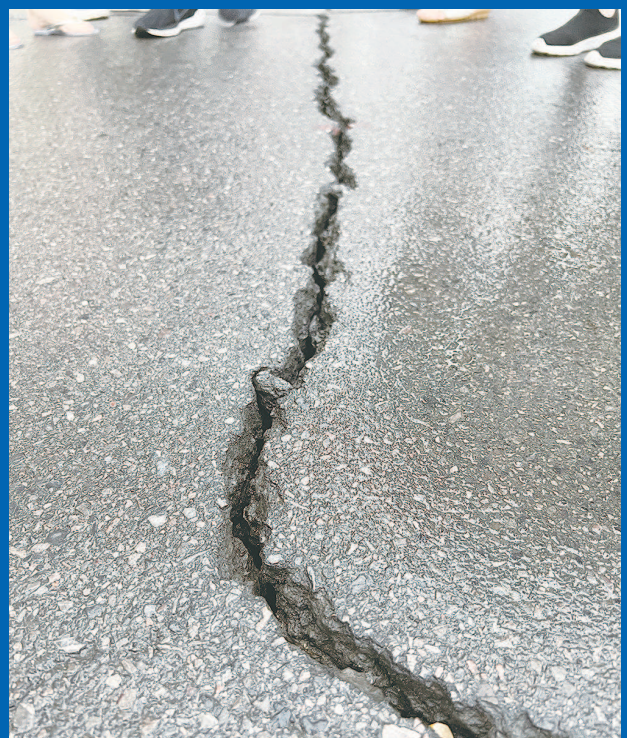
▲ 小区道路上的裂缝最宽处达两三厘米 ▲ 居民家中的瓷砖也发生开裂 ▼ “肇事”工地已经停工 本报记者 房浩 实习生 徐大伟 摄
