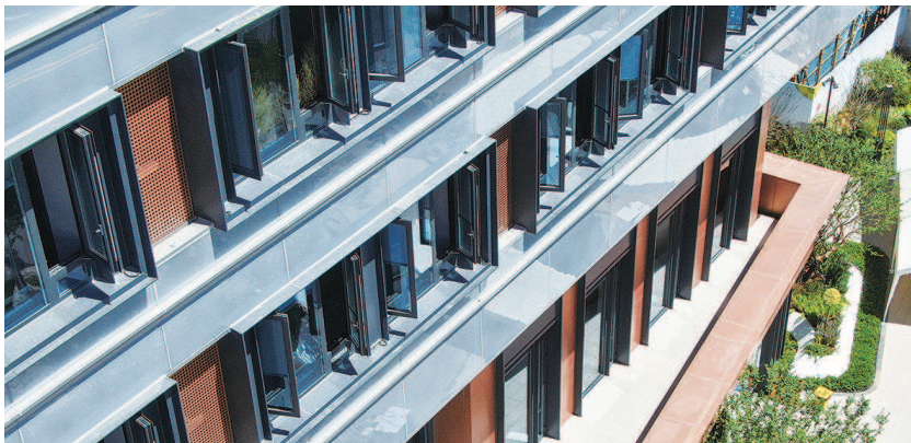
这座五层办公楼主要依靠太阳能光伏屋顶以及建筑四、五两层西立面的光伏幕墙“自己发电”，可以实现用电自给自足
