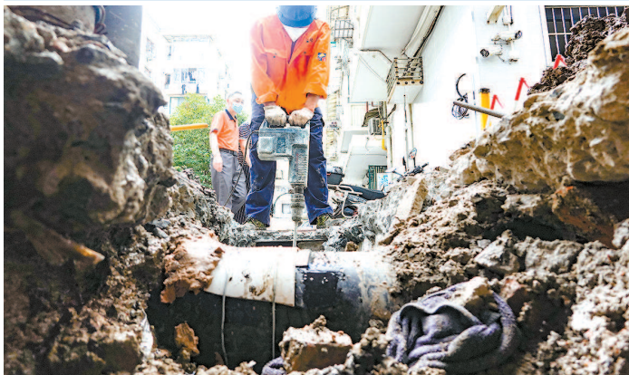
■ 黄浦区应急维修中心维修队员在瞿溪路1003弄更换下水道
