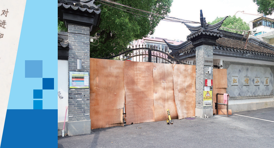
■ 虹储小区虹桥路1041弄大门封闭
