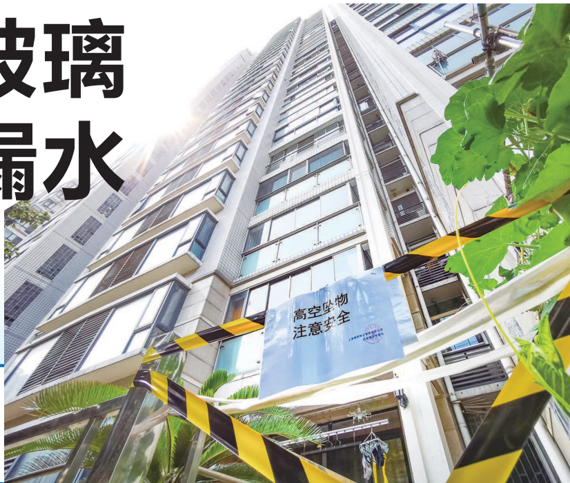
居民楼外拉起「高空坠物」警戒线
