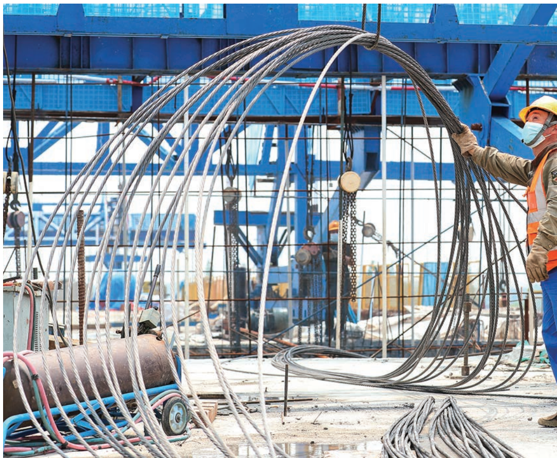
5月27日,上海松江沪苏湖铁路项目制梁现场,工人们正在加紧施工
