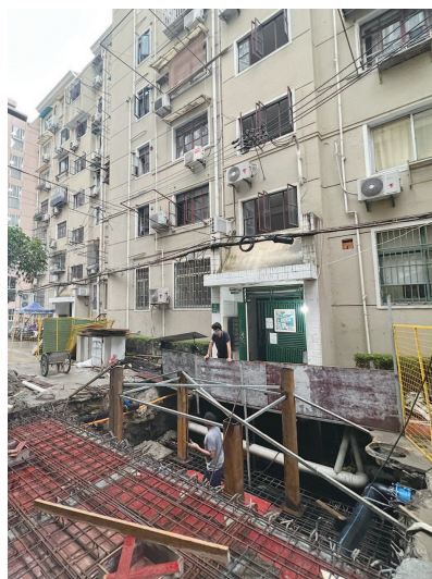
■ 蒙西小区内正在挖地基准备加装电梯 本报记者 周馨
