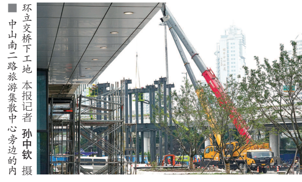
■ 环立交桥下工地 本报记者 孙中钦 摄
