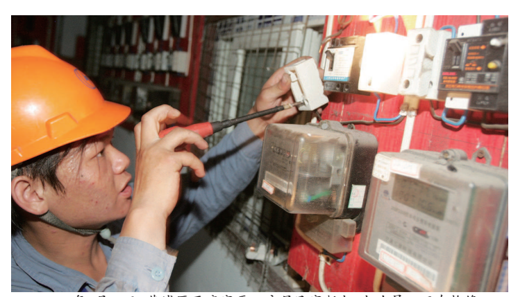
>>> 2008年7月18日,黄浦区西唐家弄一户居民家断电,电力员工正在抢修 本报记者 张龙 摄
