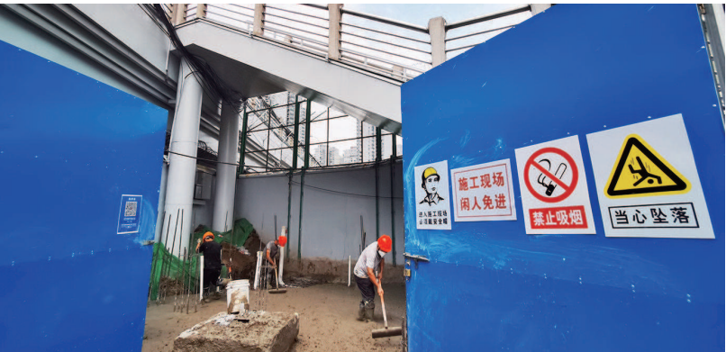
&gt;&gt;&gt; 江宁路桥北苏河岸驿站5号施工现场
