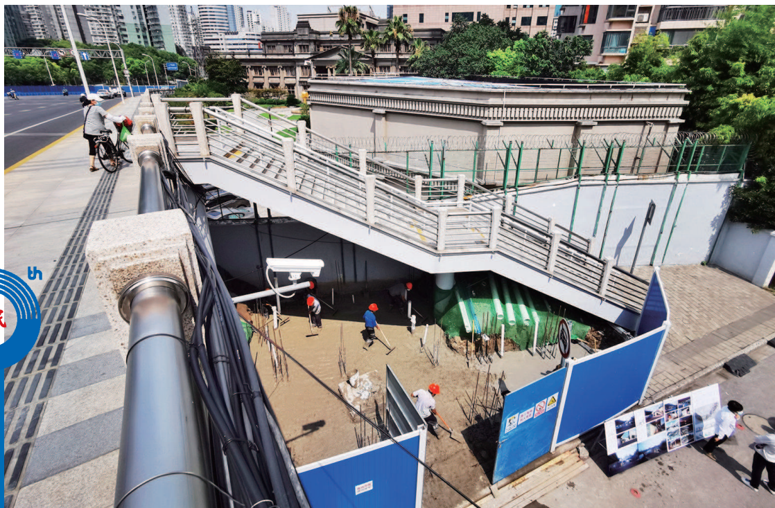
■今天上午,江浦路桥北苏河水岸驿站5号施工现场,工人正在加紧施工,该驿站预计9月底竣工
