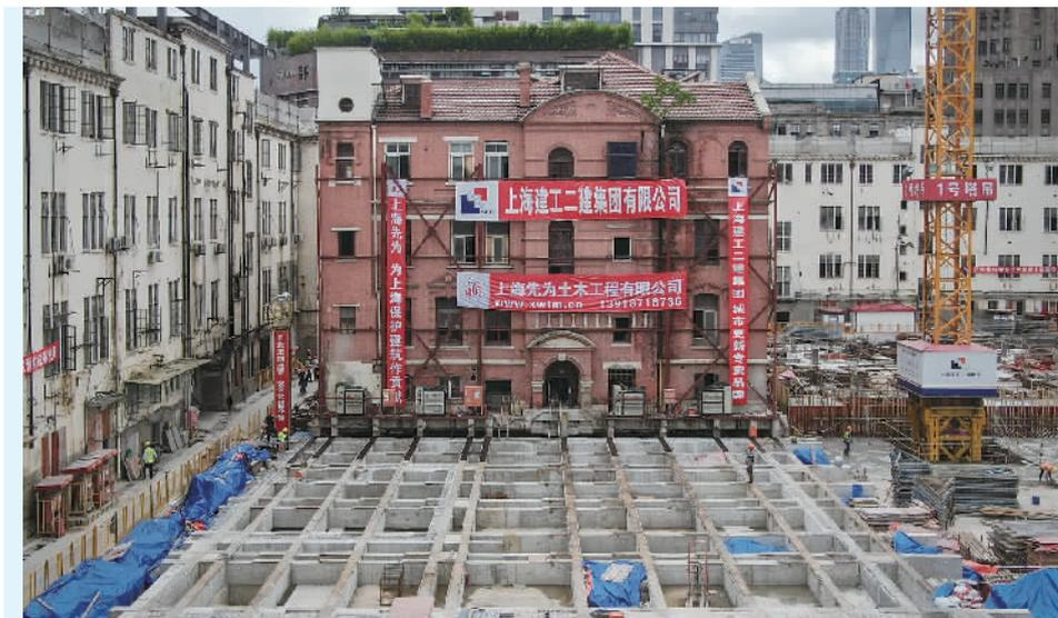
■「小红楼」平移是目前上海面积最大、重量最重的砌体结构平移工程
